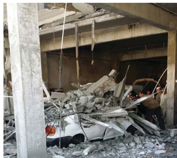
الدفاع المدني ينتشلون ضحية انهيار المبنى
